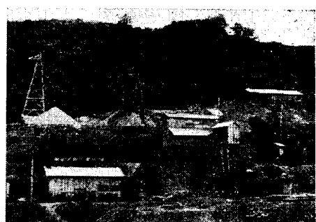
粗骨材が分離を起しコンクリートが不均等になつたので、17番目の水路橋の練り混ぜ所では、粗骨材を50~25mm, 25~5mmの2種に分け、細粗骨材を夫々3ヶ計9ヶの貯蔵ビンに入れ、少くとも24時間水を切つた骨材を使用出来るようにした。なおビンに
