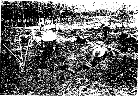
写真-2. 50年木程度の抜根作業
