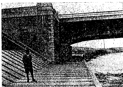
写真-5. 右岸橋臺附近コンクリート法覆工
