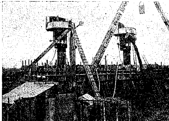
寫眞-10. P 1 潜 函 沈 下 状 況
