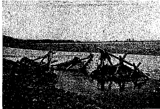
圖-121. 聖牛水制の破損
