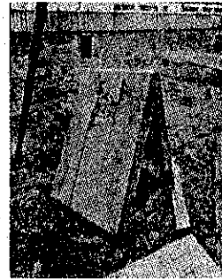
圖-10. 鋪道地下室照明窓防護用組立式コンクリート材の一例
