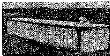
圖-18. 軌道間の如き狭地域に構築した地上式函形防護室
