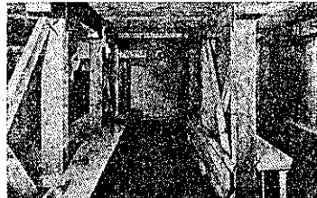
圖-7. 地下室天井補強例 (1)
