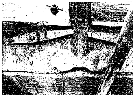
寫眞-3. c. 同上（浮扉拘止、開放装置の詳細を示す）（基隆要塞司令部許可済）
