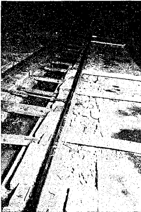
圖-20. 道床コンクリートの破壊の例(藤倉隧道其の2) 圖-21. 道床コンクリートの破壊の例(藤倉隧道其の3)
