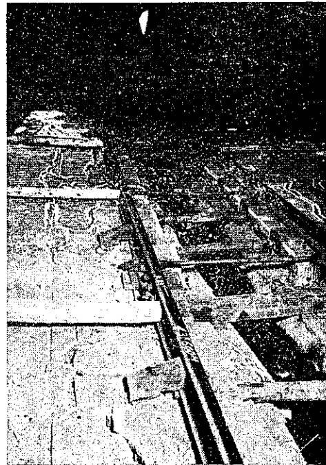
圖-20. 道床コンクリートの破壊の例(藤倉隧道其の2) 圖-21. 道床コンクリートの破壊の例(藤倉隧道其の3)
