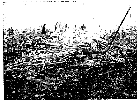
圖-3. 火災を受けた西部信號所聯動部
