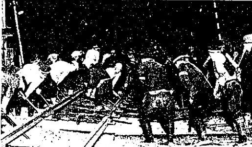
図-7. 分岐線交換作業 其の 2
