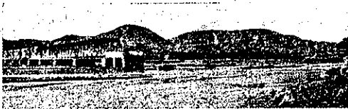
図-44. Bardsdale の Santa Clara 河橋梁、一つのスパン 30 ft のものが 9 径間流された
