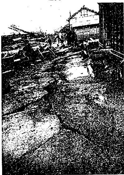
圖-21. 昭和 14 年 5 月 1 日發生船川線 震害狀況 脇本驛構内貨物通路に 生じた龜裂
