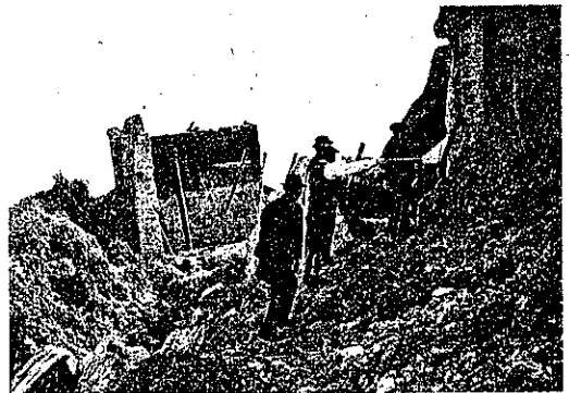
図-8. 船川水道タンクの破壊
