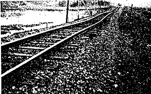
図-18. 昭和 14 年 5 月 1 日發生奥羽線 震害状況森岳織間 352k 750m 附近線路通り最大約 700 mm, 高低最大約 1 m 移動の状況
