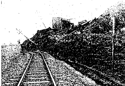
圖-19. 昭和 14 年 5 月 1 日發生船川線震害狀況 羽立船川間 25k610m 附近右側丘陵崩壊と（延 長約 40 m 高軌道中央にて約 5 m）線路移動埋 没の狀況
