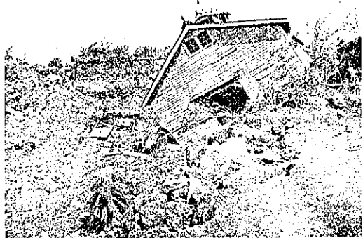
図-11. 北浦町東部陥没地の東端に在る家屋
