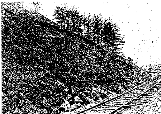
圖-22. 船川線羽立脇本間の空積擁壁の崩壊
