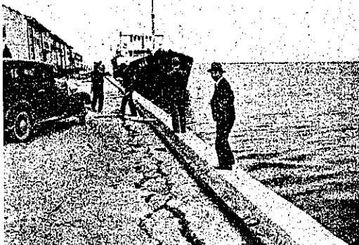
圖-13. 船川港岸壁盛土部分の沈下
