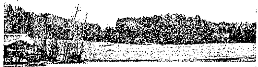
図-20(6). 丸森堤(中央は沈下してゐる)
