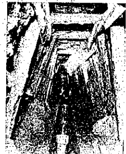
図-7. 右岸段丘基礎のセメント注入孔
