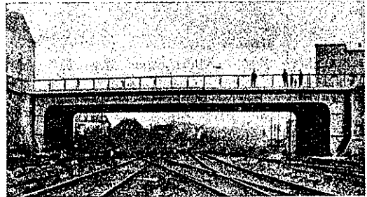
図-85. 鉄道上の2鉸ラーメン橋
