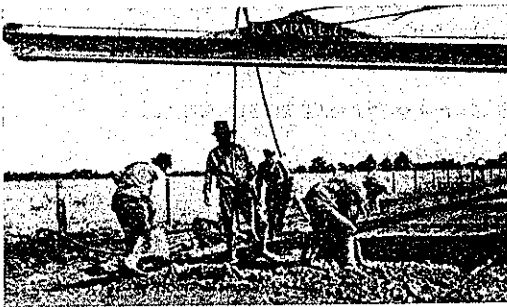
図-74. 道路舗装コンクリート施工は普通の場合よりは一寸能率が悪かった。接目の傍を施工する時には正しい位置に接目材料を設置する様に注意が行はれた。
