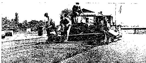
此の航空港は W.P.A. の計画であつて出来得る限り多數の人を雇用しなければならないから砂岩は人力によつて粉碎した。石灰石を舗装混合物に最もよく利用する爲に、West Virginia 道路協会の試験の結果媒熔アスファルトを用ひた 2 層の工場配合の舗装が適する事が解つた。
