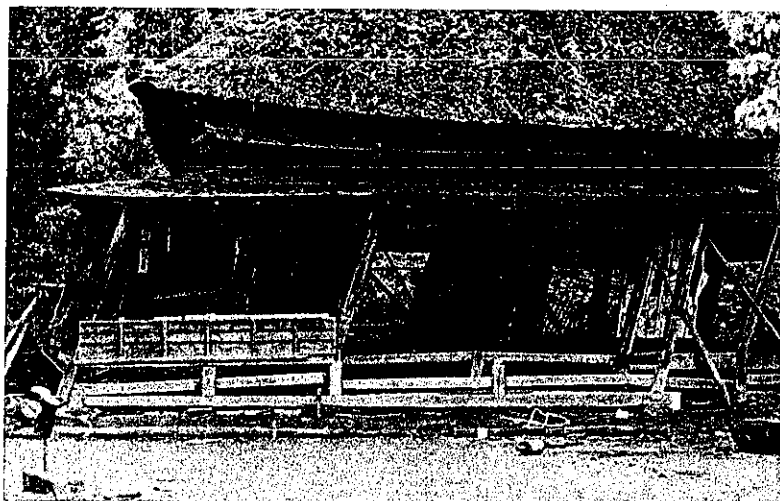
五里合村琴川部落に於ける 農家の半潰状況 (構造は良好である)
