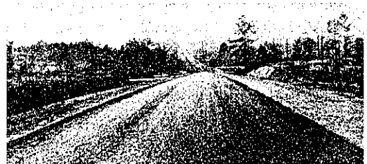
圖-37. 表面處理をなした topsoil よりなる Georgia 州の代表的土砂道
