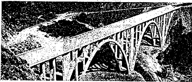
図-86. 橋梁の諸負金額は 1 平方呎に付き 10.22 弗であつた、設計では有効幅員 24 呎にして 8 000 yd 3 のコンクリートを要した
