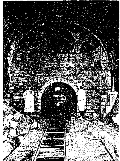
圖-7. 防護コンクリート塊積
