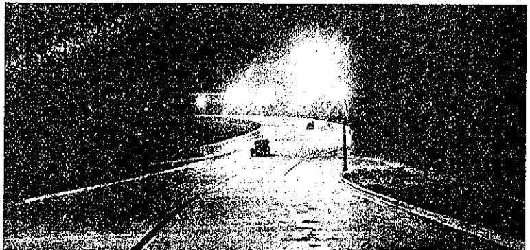
図-27. 下路交叉の照明の一例
