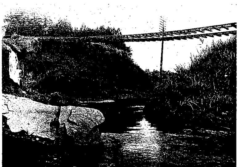
常磐線赤塚・綠岡間第 1 澤渡拱橋築堤崩壞狀況
