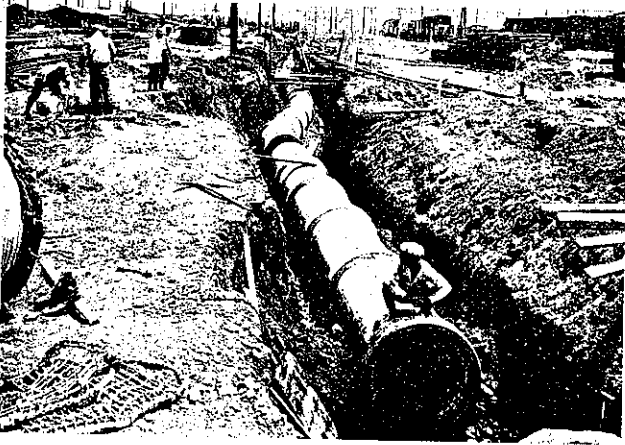
帝國ニュービューム管埋設状況
