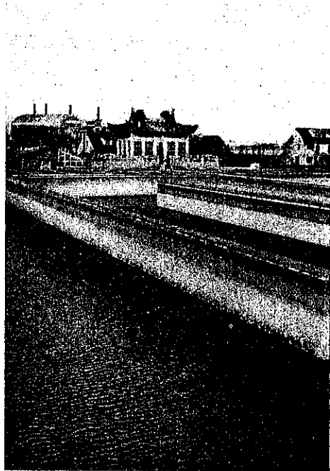
図-13. 開北水道浄水場の沈澱池
