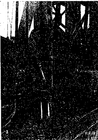
図-3a. ウォーターゼットにより鉄杭を垂直に打込む図
