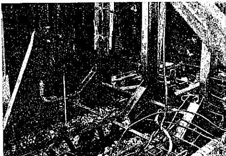
圖-7(a). 下床版鉄桁組立圖
