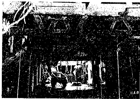
図-11. 上床版にコンクリートを手打ち込みせるところ
