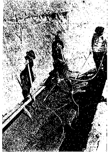
図-16. 拱部コンクリート打にバイブレーターを使用するところ
