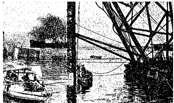
図-12. 基礎杭打作業(丙岸壁)
