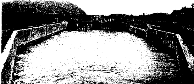
満水せる沈砂池（下流を見る）
