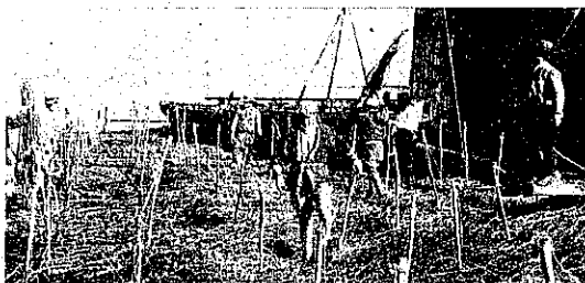
図-13. 4 號橋脚根固用沈床工組立の状況
