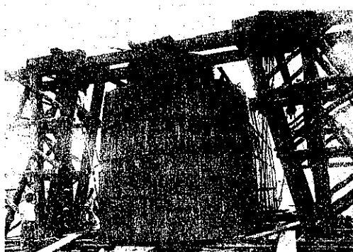
図-15. 4 號橋脚井筒用鋼沓据付の状況
