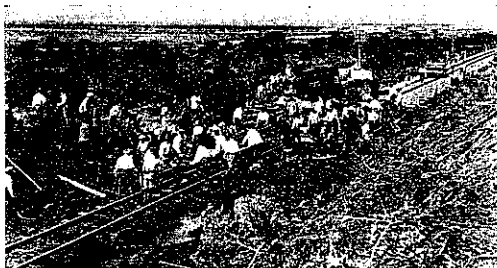
脱線車両取付後の復旧作業 (昭. 11. 10. 4)
