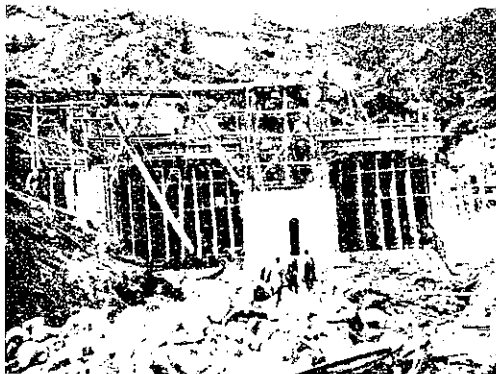
図-7. 工事中の小野川発電所
