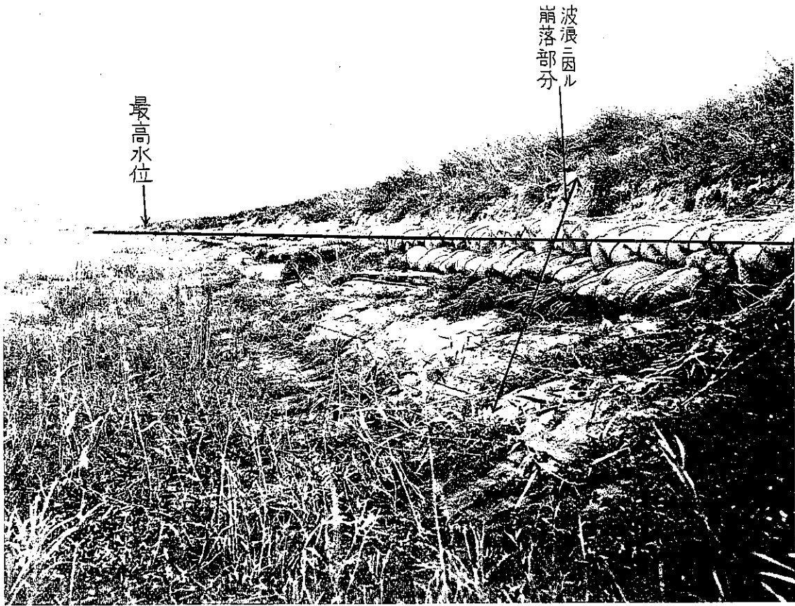
(3) 堤防表法の波浪に因る崩落箇所防水工作の跡
