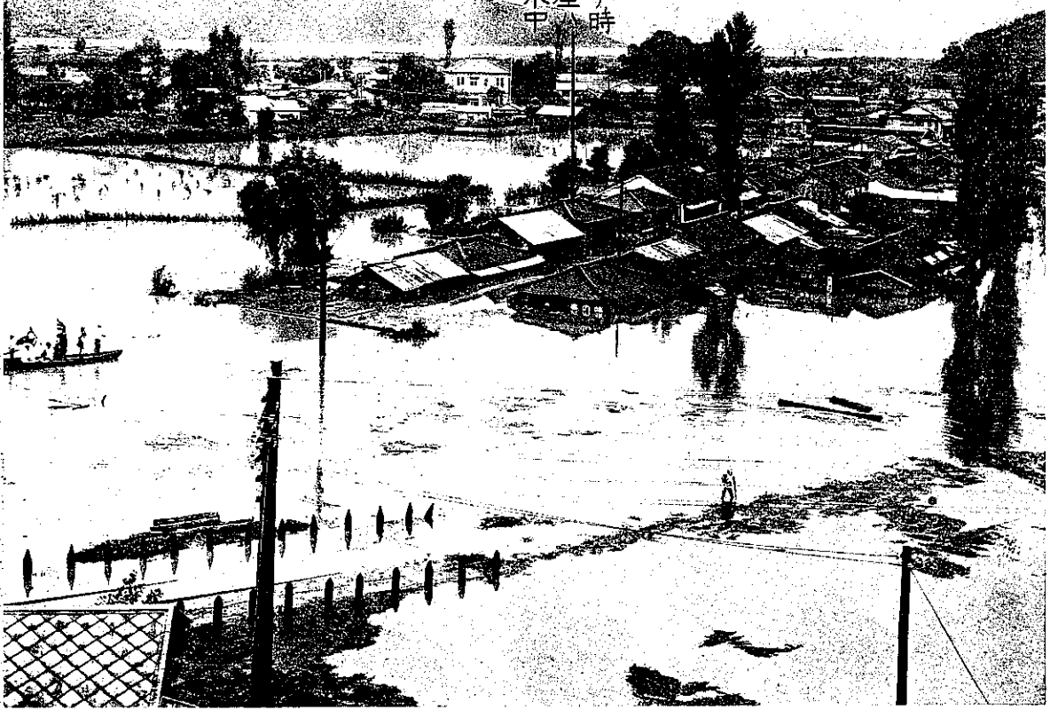
(1) 無堤防地域の洪水氾濫状況
