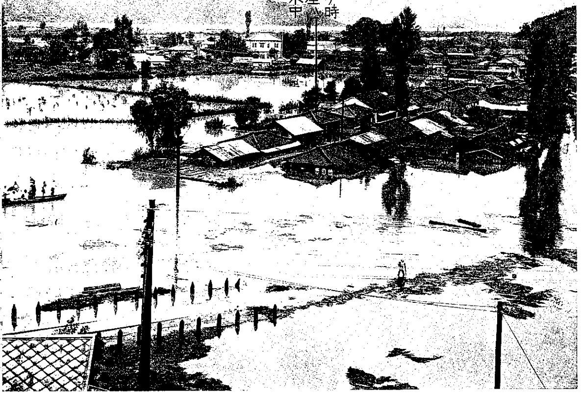
(1) 無堤防地域の洪水氾濫状況
