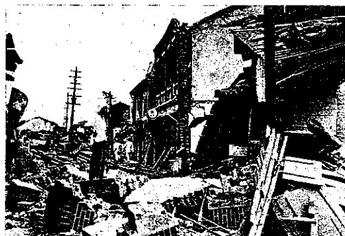
圖-53. 市街の被害 (臺中州大甲郡清水街)
