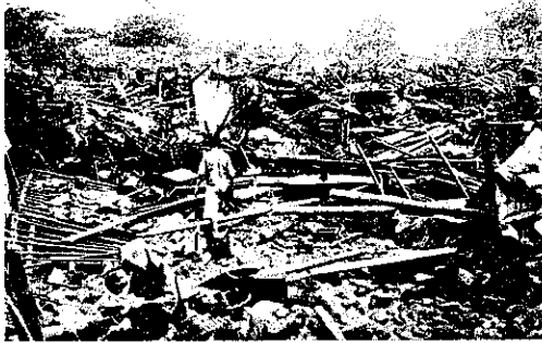
図-44. 土角造の崩壊の一例 (新竹州竹南郡南庄)
