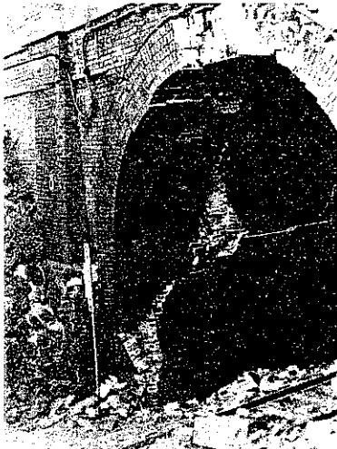
圖-35. 第 8 隧道北口の崩壊
