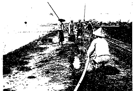
圖-14. 堤防天端龜裂填充作業 (同上)
