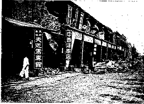
図-47. 煉瓦土角混用建物の崩壊 (臺中州大甲郡沙鹿庄)
