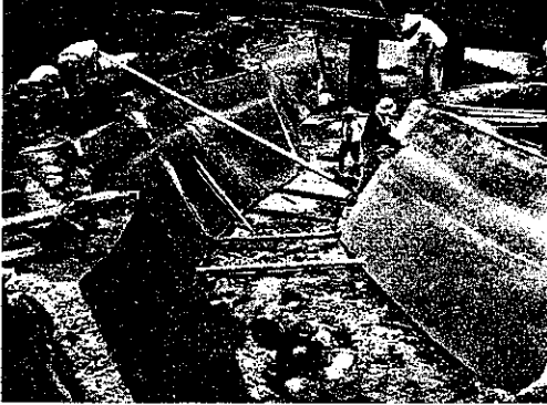
図-17. 開渠敷コンクリート打練場及び運搬 (同上)
