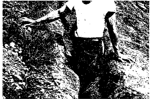
圖-14. 堤防天端龜裂填充作業 (同上)
