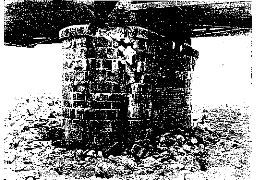
圖-32. 大安溪橋梁橋脚の被害
