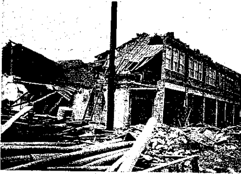
図-49. 煉瓦半枚積二階建の崩壊 (臺中州大甲郡沙鹿庄)
