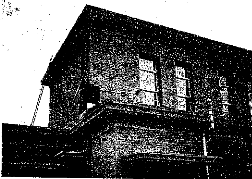
図-51. 煉瓦造被害の一例 (沙鹿警察官吏派出所)
