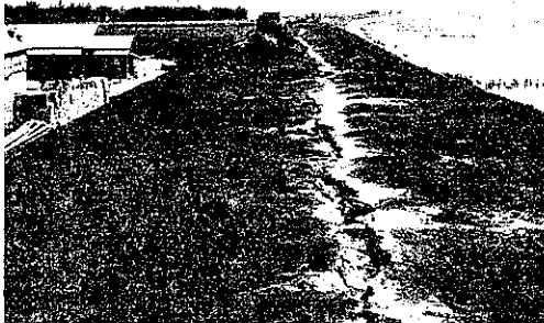
圖-12. 堤防の龜裂 (臺中州大甲郡龍井庄汴子頭)
