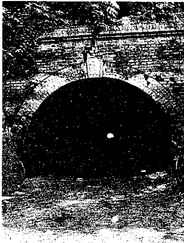
図-19. 第3號隧道震害龜裂
