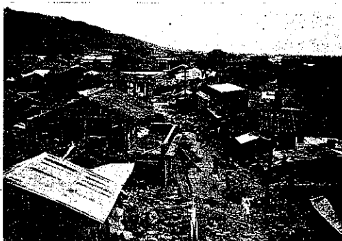
圖-55. 臺中州大甲郡清水街の被害狀況 (土角造は破潰され煉瓦造、木造、コンクリート造等は崩して死れたり)
