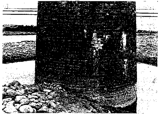
圖-28. 後龍溪橋梁橋脚の龜裂
