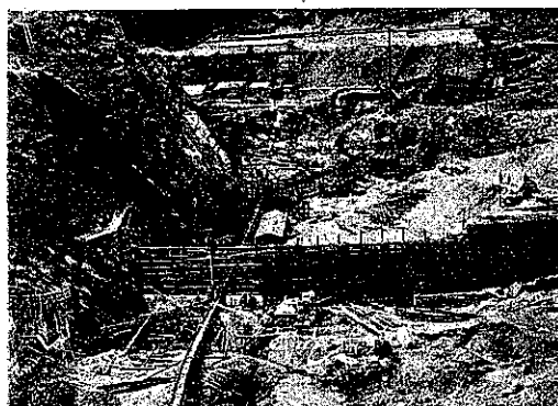
寫眞-2. 大井川堰堤第三個締切工事(上流より望む)
