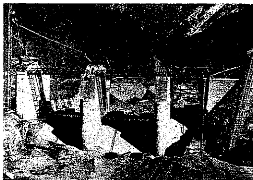
寫眞-3. 大井川堰場工事(下流より望む)
