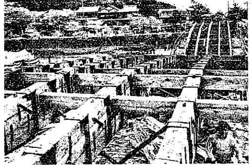
図-11. 桁巻金緊結状況
