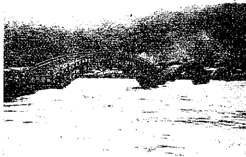
図-14. 非常洪水時に於ける錦帯橋
