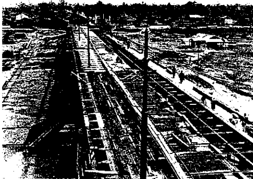
片側の歩道車道コンクリート一部打終り状況
