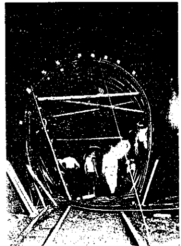
図-7. 東海道本線驛由比興津間 162 km 160 m 附近上線隧 道内変状箇所應急補強レ ールセンター建込状況
