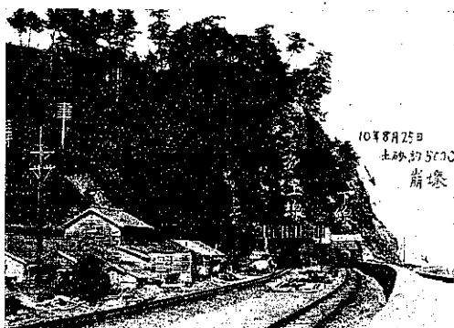
圖-1. 東海道本線由比・興津間 162 km 325 m 洞隧道西口附近
