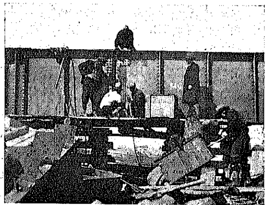
第9圖 浮船にて對重桁絞鉄
