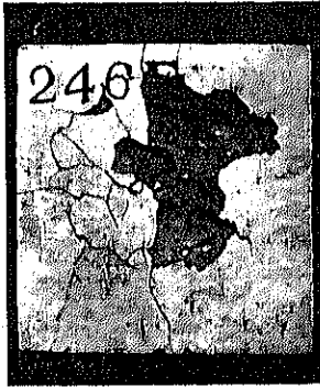
73. 前圖の裏面, 第1回には裏面異状なく, 第2回の射撃に於て圖の如く破壊せり
