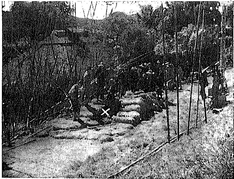
第 7 圖 利根川筋安食町地先堤防法先の水防 (× 印は漏水箇所)
