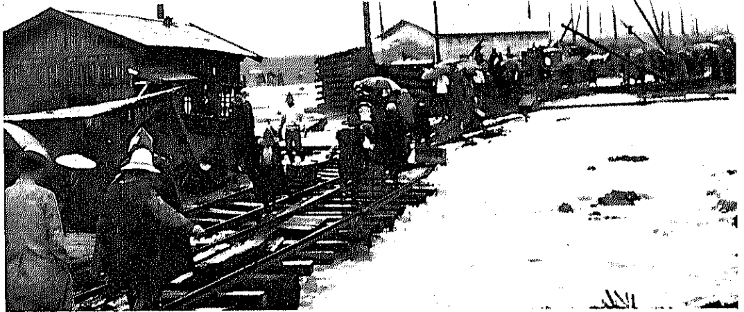
大鰐驛の南方を流るゝ平川の堤防決壊し、奔流大勢全線を繞り廻りに大鰐驛を襲ひ構内の線路を河流したる状況 (昭和 19. 8. 25 午後 10:30 撮影)
