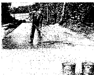
7. 溶液を表面に平に帯でならす
