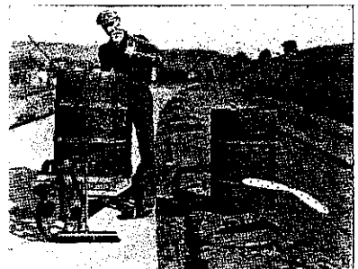
3. 塗布の爲に溶液を作る場合は水硝子液を 36°~37°Be 或は水硝子 4 に對し水 1 の割合に薄める
