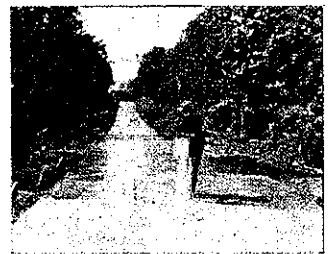
6. 常に等の前方に水硝子溶液を流しつゝ、塗布 する
