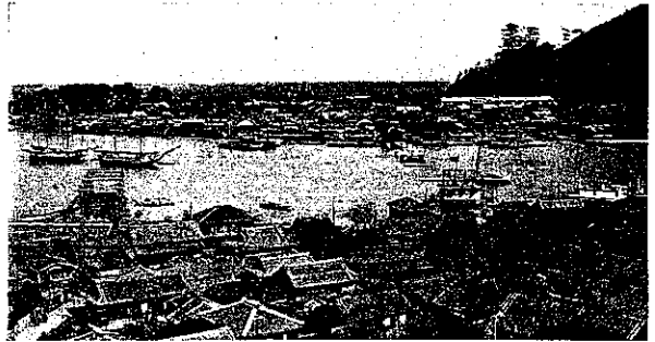
第 1 圖 工事場全景
