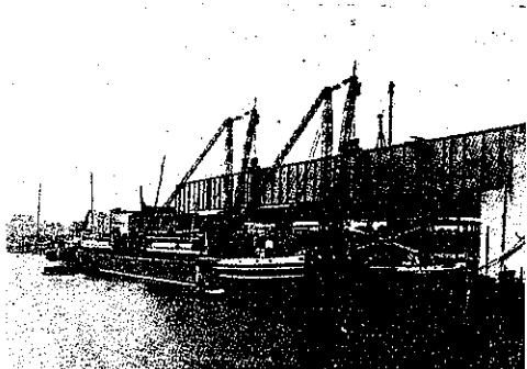
第 14 圖 桁の据付
