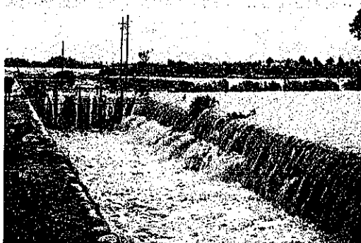
堤防破壊により田地並に排水路に浸水の状況、舊堤より下流を望む 昭和9年7月11日午後3時
