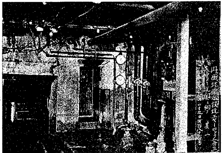
第 2 圖 北側水抜坑空氣閘門正面
