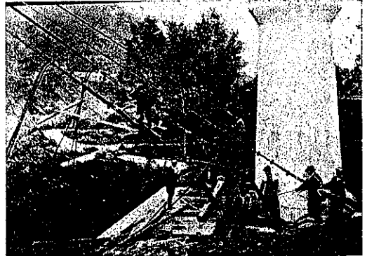
第 5 圖 アンカーの箇處でトグルを働かす
