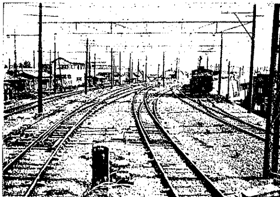
第十三圖 曲線路に用ひたる普通分岐
