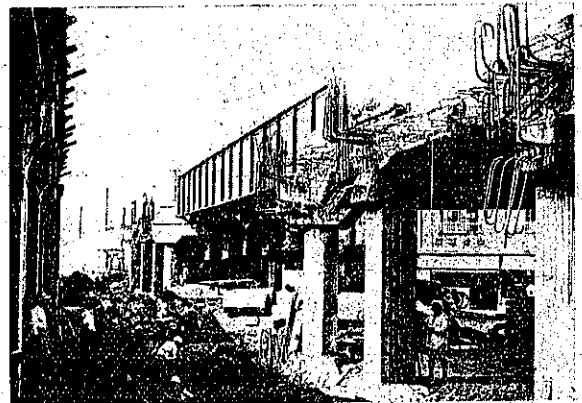
第五圖 工事中のラーメン橋臺
