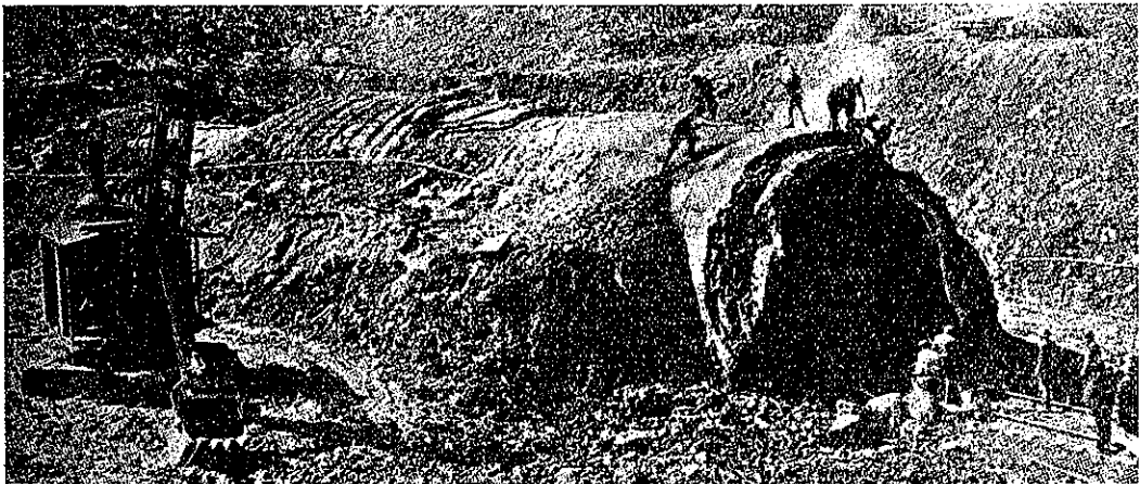
寫眞第五 舊覆工の爆破
