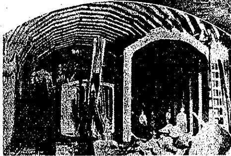
寫眞第五 舊覆工の爆破
