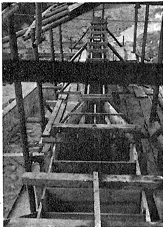
寫眞第九 流量2個, 流速2.2呎の場合に於ける 留砂室内土砂堆積状態
