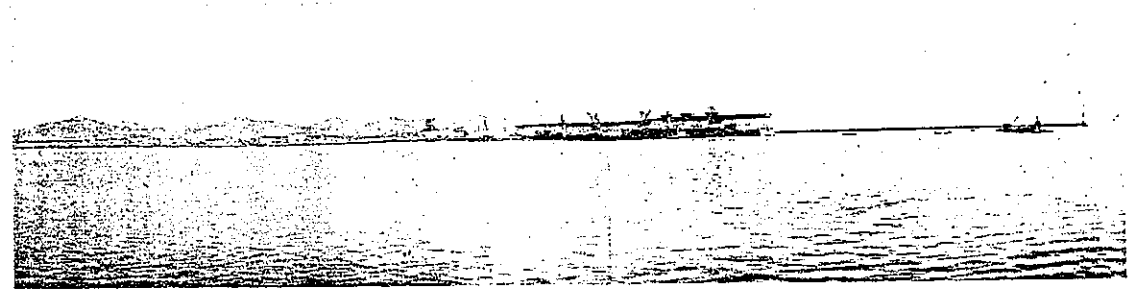
写真第二 竣工せる甘井子埠頭 (其の一) (昭和5年12月撮影)
